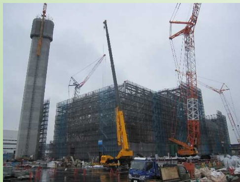
建築・煙突工事
