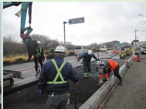
周辺道路工事
